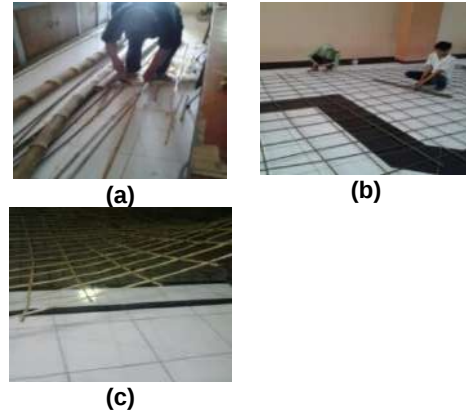
Gambar 1. Rangkaian ( meshing ) tulangan (a) Batang bambu yang dibelah; (b) Meshing tulangan baja; (c) Meshing tulangan bambu
